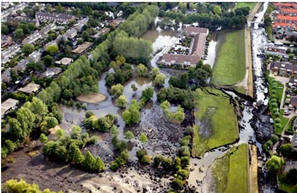
Figuur 2-7 Kade-doorbraak bij Wilnis. Rechts is de watergang te zien die nagenoeg volledig is leeggelopen
